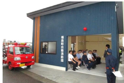
新築の自衛消防団格納庫
