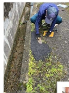
仕上げに転圧をしてこれで安全! 作業完了
